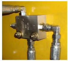
**Балансирующая блокировка рычага** регулирует давление гидравлической жидкости, задерживающейся в подъемных цилиндрах для системы выравнивания домкратов буровой установки.
