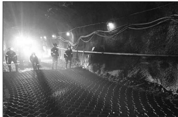
Работники дорожного участка растягивают георешётку
